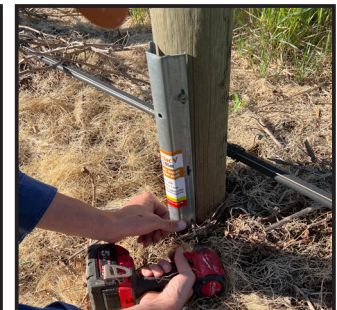
Ocloc V-NZ - screwing
